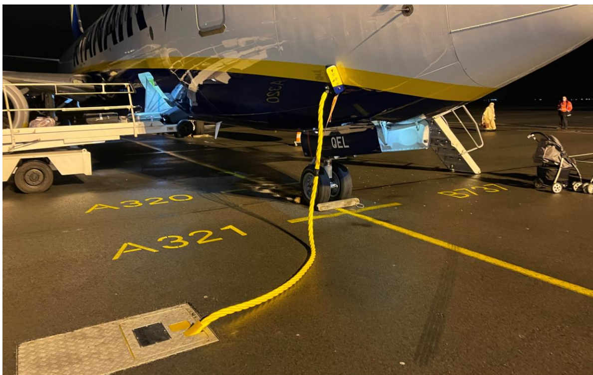
Avion connecté au réseau d'infrastructure 400 HZ ©Aéroport Paris-Beauvais
